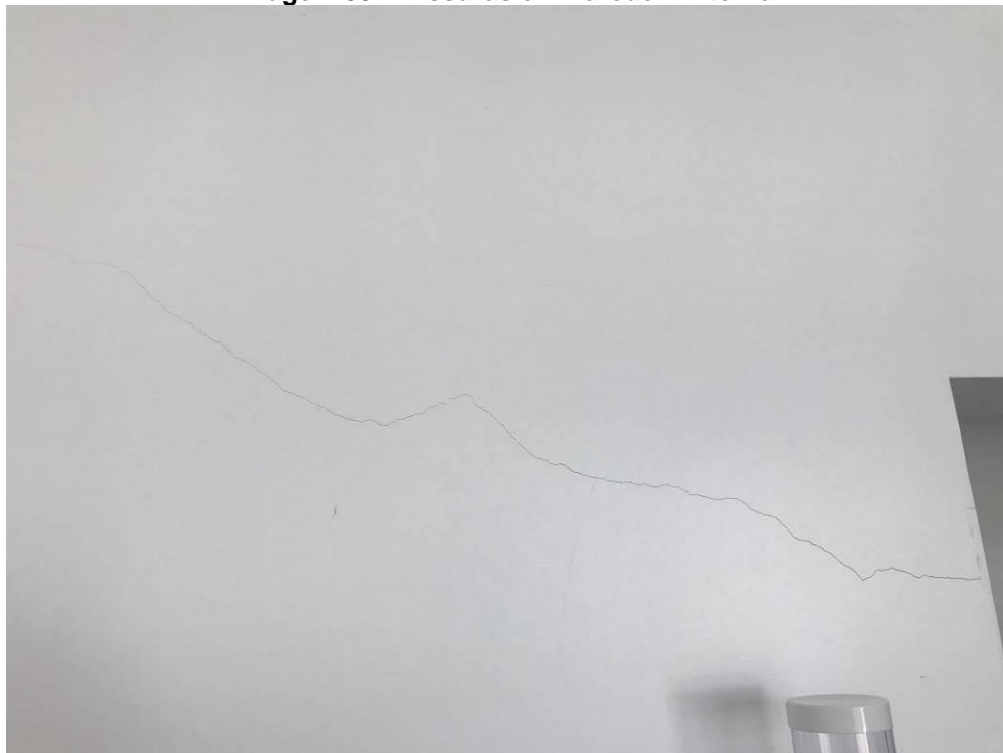
Imagem 39 – Fissuras em Parede – Interna.
