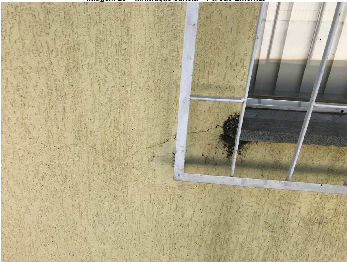
Imagem 28 – Infiltração Janela – Parede Externa.
