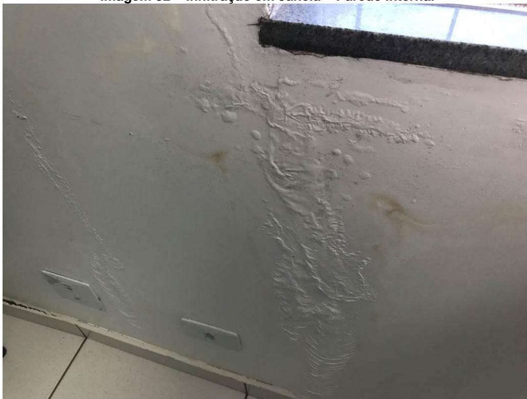
Imagem 32 – Infiltração em Janela – Parede Interna.
