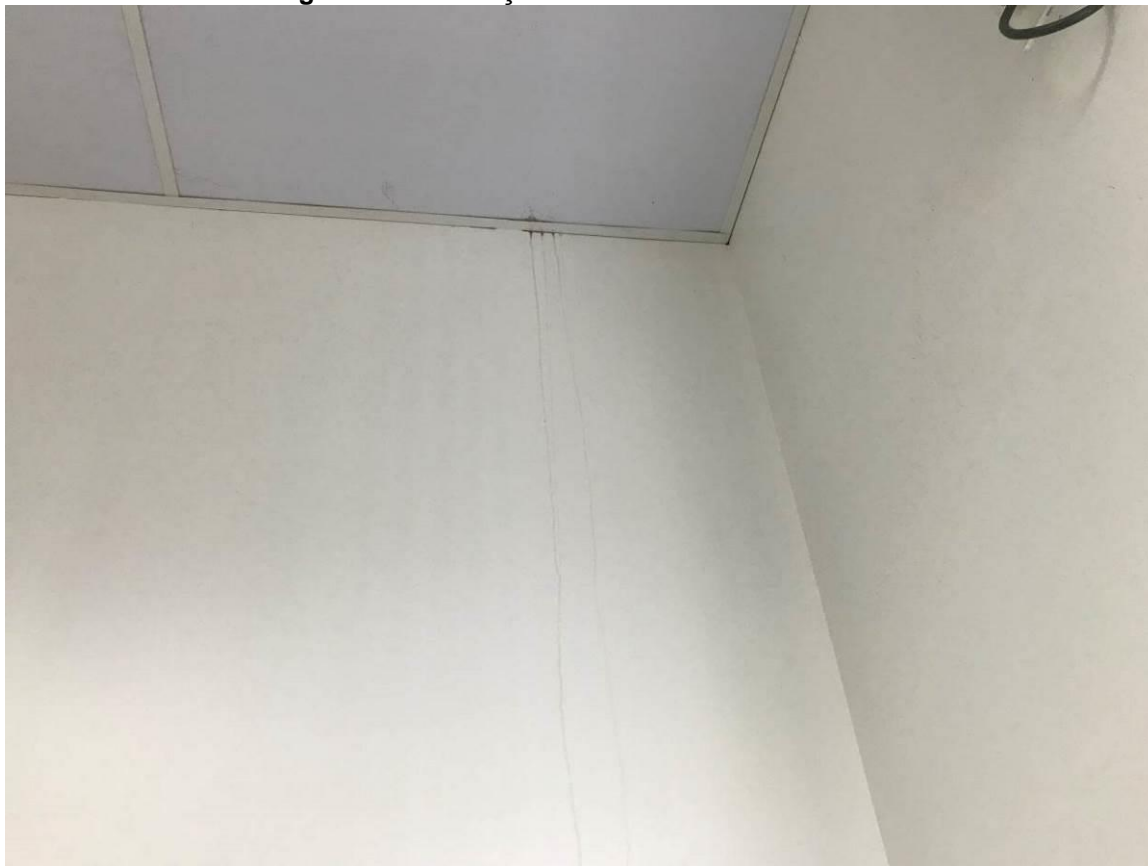
Imagem 37 – Infiltração – Parede Sala de Audiência.
