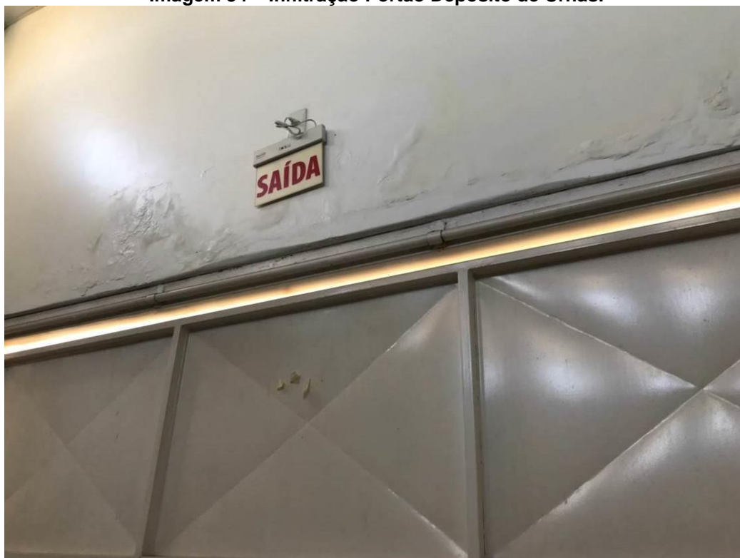
Imagem 34 – Infiltração Portão Depósito de Urnas.
