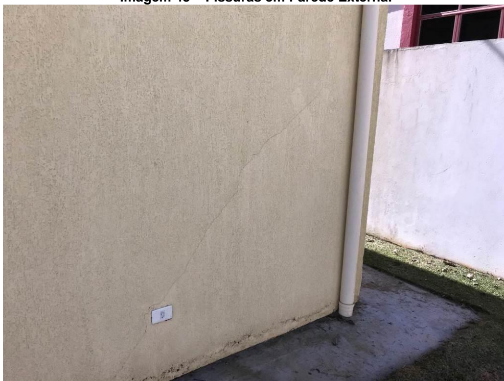
Imagem 43 – Fissuras em Parede Externa.
