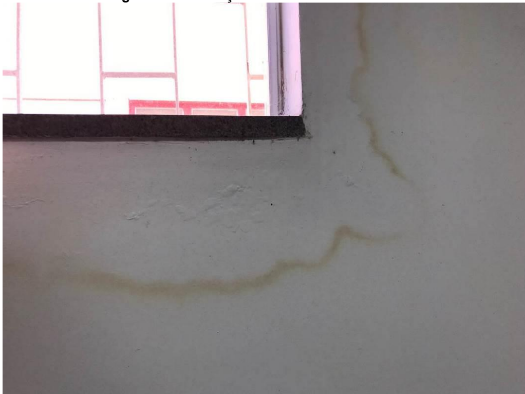
Imagem 31 – Infiltração em Janela – Parede Interna.
