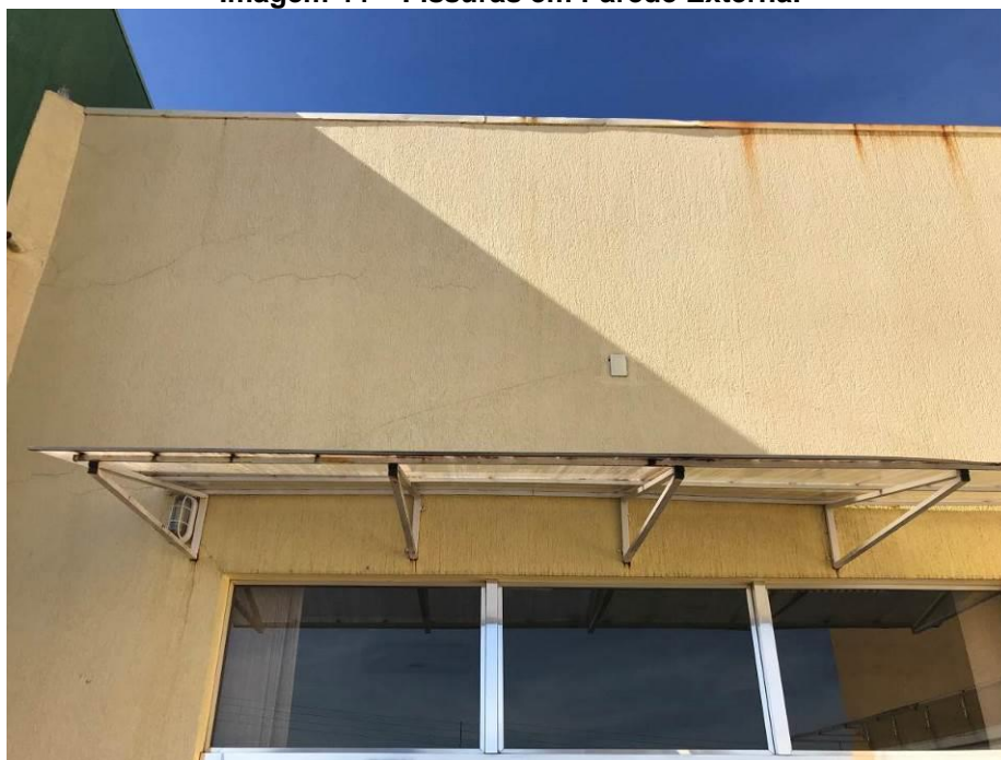
Imagem 44 – Fissuras em Parede Externa.
