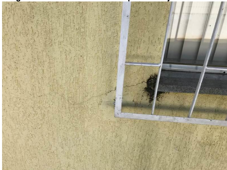
Imagem 41 – Fissuras em Parede próximo à janela – Externa.
