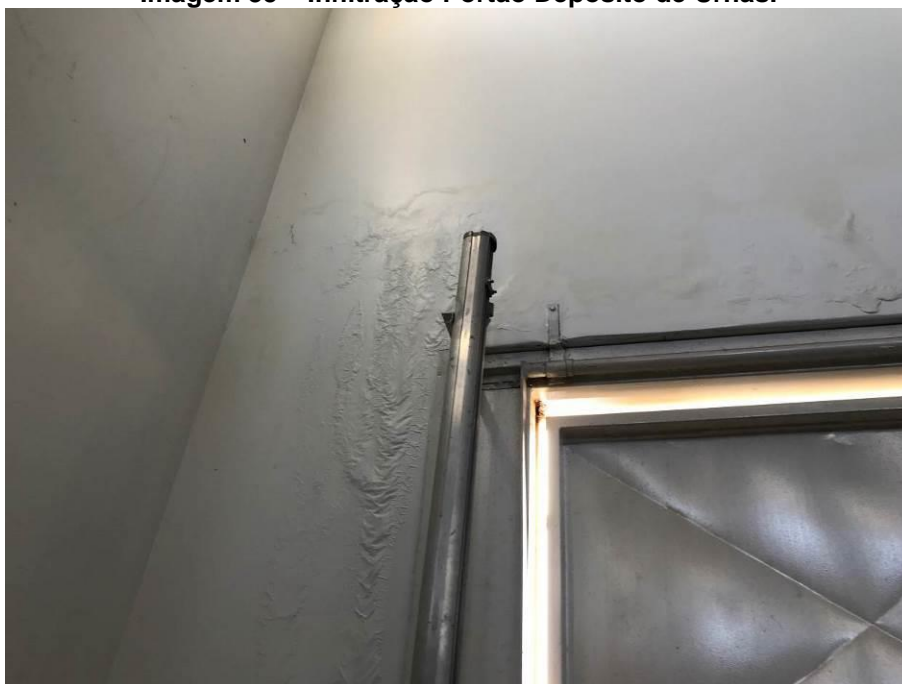
Imagem 35 – Infiltração Portão Depósito de Urnas.
