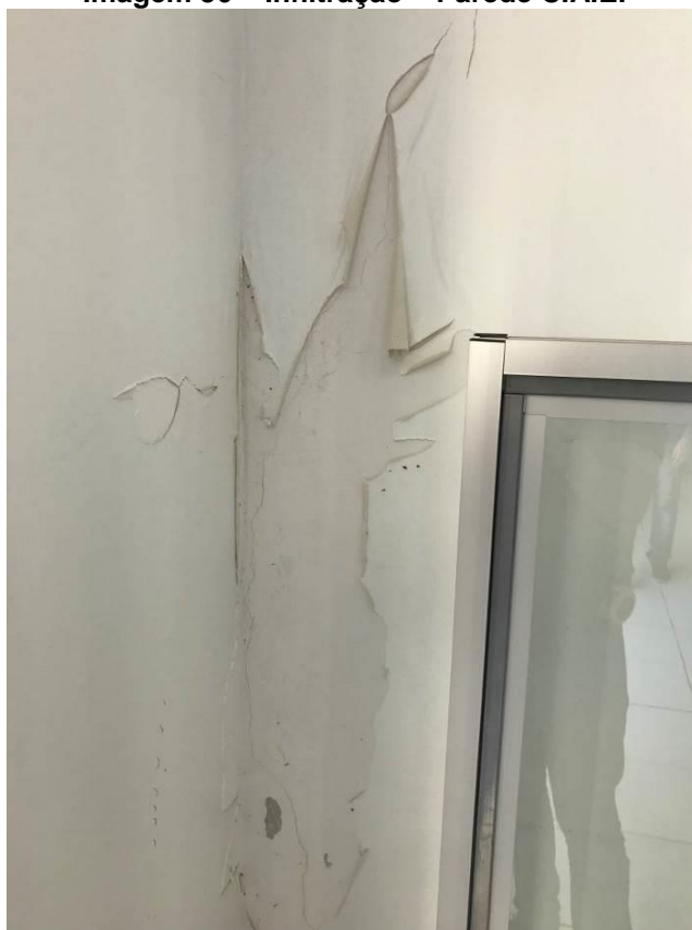
Imagem 36 – Infiltração – Parede C.A.E.
