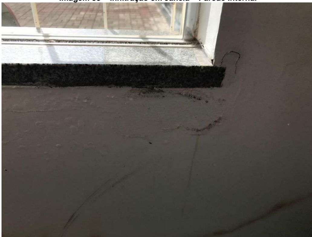
Imagem 33 – Infiltração em Janela – Parede Interna.
