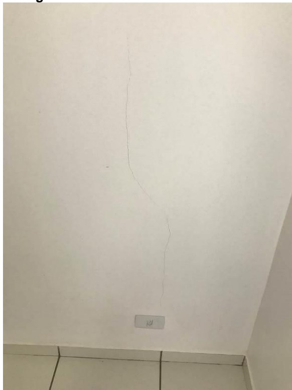
Imagem 38 – Fissuras em Parede – Interna.
