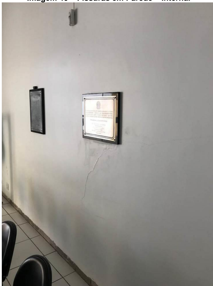
Imagem 40 – Fissuras em Parede – Interna.
